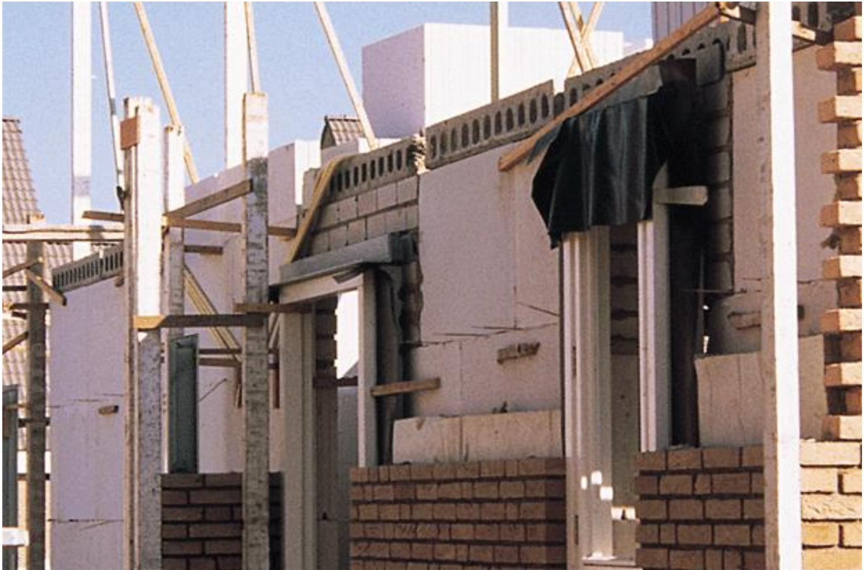
Fig. 16. Questa foto, scattata in un cantiere in Olanda, mostra come il coordinamento dimensionale in altezza fra murature e pannelli isolanti consente l'inserimento dei graffaggi in corrispondenza delle giunzioni fra un pannello isolante e l'altro.
