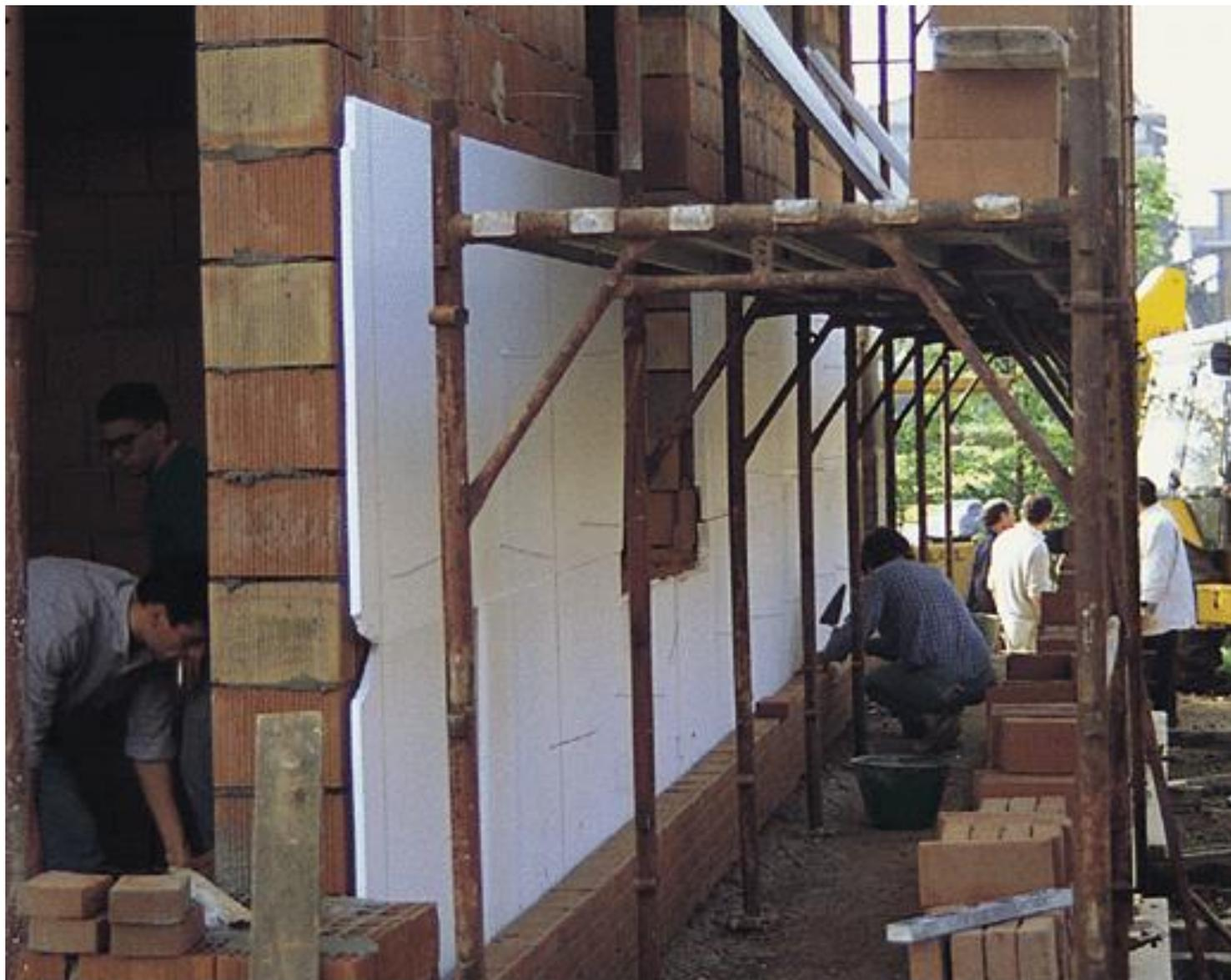
Fig. 17. Se la posizione dei graffaggi, legata a quella della muratura, non è coordinata con la dimensione dei pannelli isolanti è necessario effettuare un taglio o un forellino per consentire l'attraversamento di ogni grappa.
