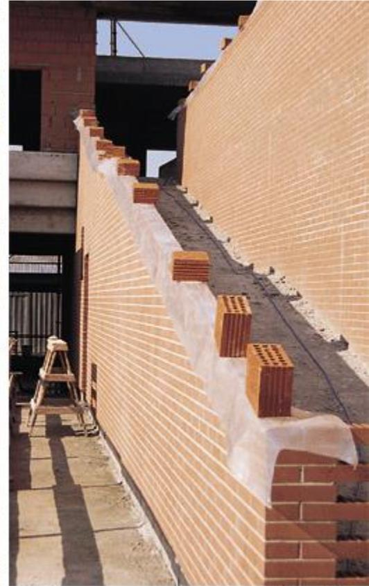
Fig. 1-2. Fino alla posa delle copertine, la sommità delle murature deve essere protetta dalle intemperie.
