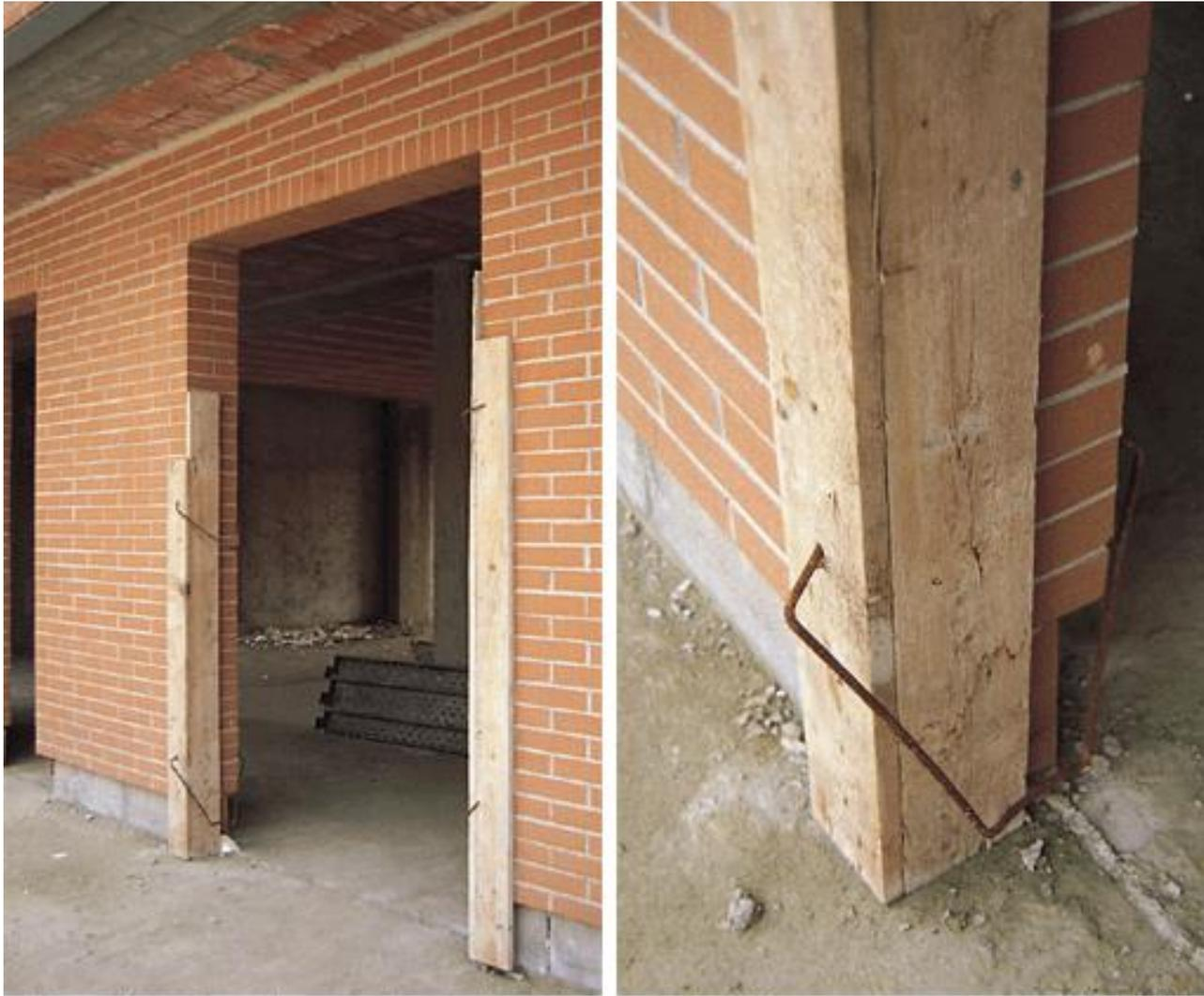
Figg. 13-14. Protezione degli spigoli mediante tavole di legno ancorate con una "molla" in ferro, anziché mediante chiodi.
