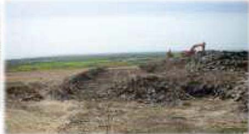
Rifiuto rimosso da Cava Gentile e abbancato sul corpo principale della discarica: 17.600 mc
