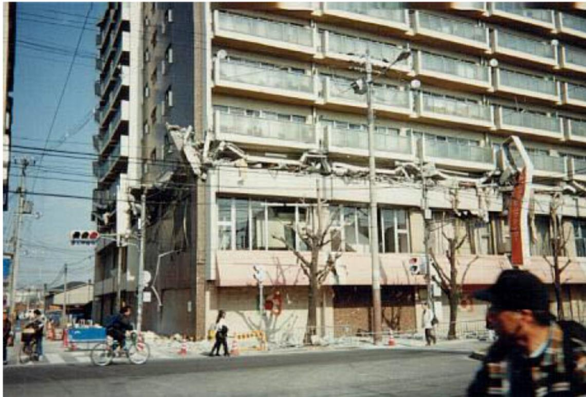
Kobe 1995  $M_w$  6.8 – Il collasso è avvenuto al terzo piano. Probabile irregolarità in altezza nella distribuzione delle masse o delle rigidezze.
