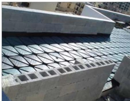
Un tema sempre più importante degli ultimi anni è l'eccessivo consumo energetico degli edifici, consumo che è possibile ridurre in modo considerevole attraverso un'intelligente variante di impiego dell'Iglu®: la ventilazione del tetto. Posizionando sulla copertura orizzondale dell'edificio i casseri Iglu® si viene a creare un'intercapedine d'aria che permette di isolare dal caldo in estate e dal freddo in inverno, con conseguente risparmio nella climatizzazione degli ambienti interni.
