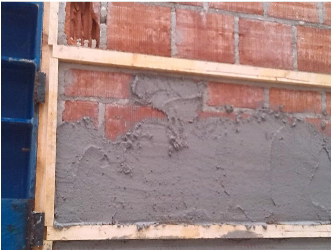
Figura 2.16 - Realizzazione primo strato d'intonaco
