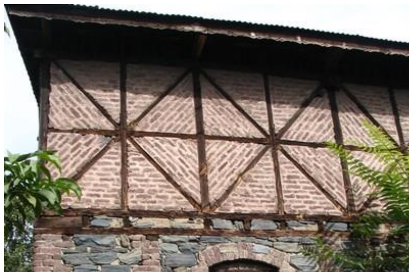
Figura 1.10 - Esempio di edificio in dajji-dewari (2013)
