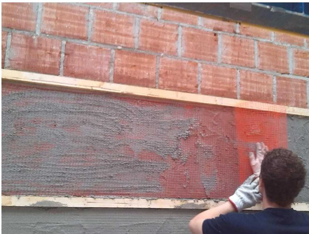
Figura 2.17 - Messa in opera del primo strato di rete di armatura
