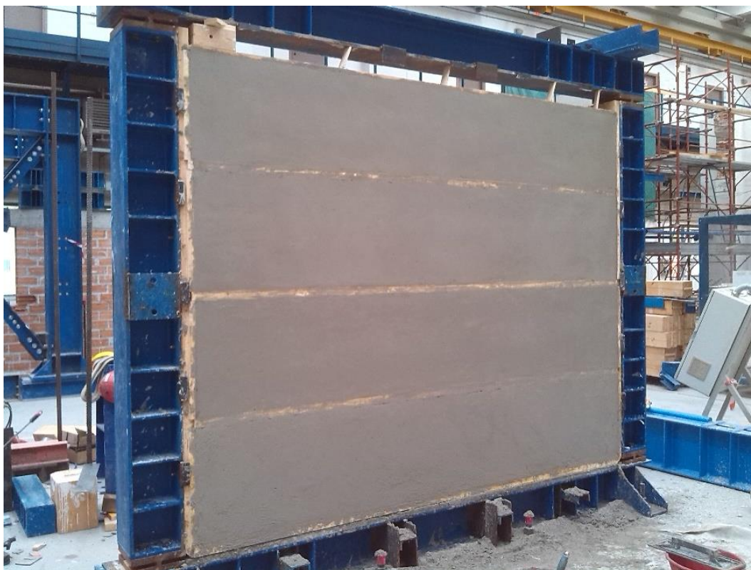
Figura 2.19 - Tamponamento dopo la realizzazione dell'intonaco
