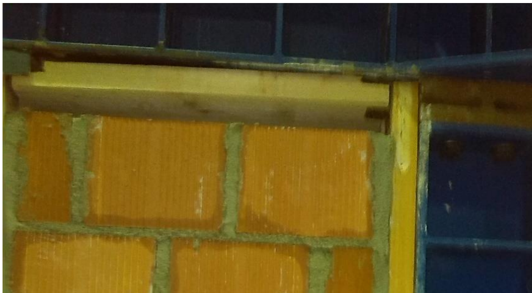
Figura 2.24 -Particolare del gap tra muratura e trave superiore
