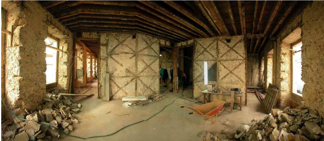
Figura 1.3 - Esempio di gaiola pombalina (Bai15).
