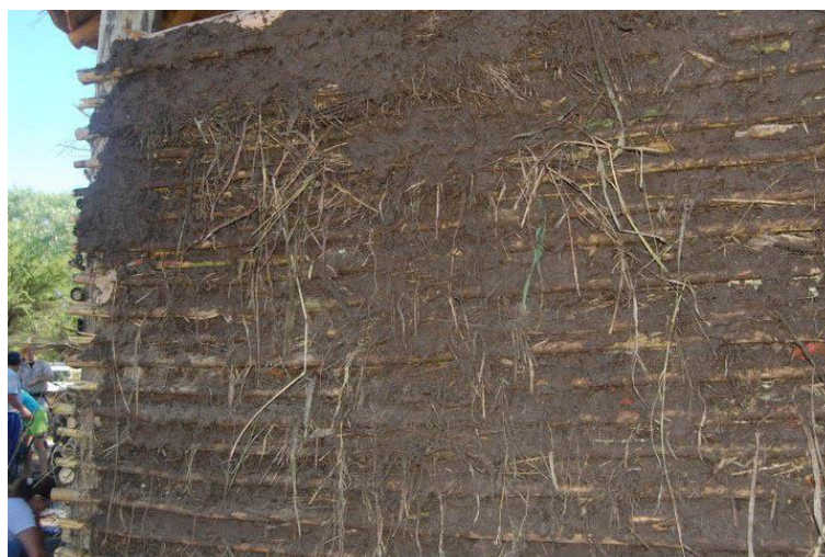
Figura 1.13 - Esempio di parete realizzata con tecnica quincha
