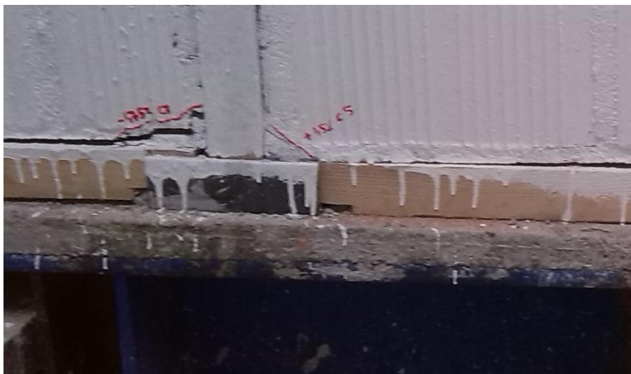
Figura 5.30 - Esempio di distacco locale degli angoli di malta
