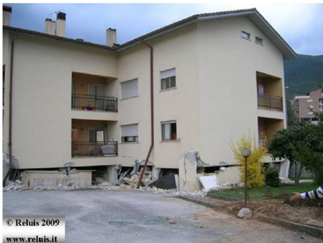
Figura 1.1 - Terremoto dell'Aquila 2009: un edificio in c.a. parzialmente crollato e con vistosi danni ai tamponamenti
