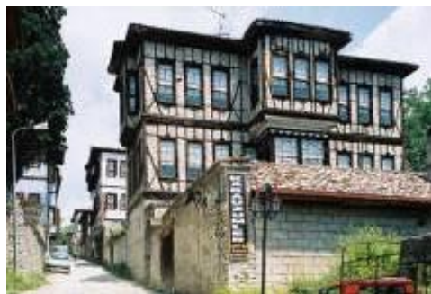
Figura 1.5 - Esempio di edificio realizzato con tecnica himis (Langenbach, 2006 B).
