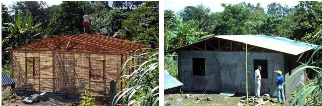
Figura 1.14 - Edificio sperimentale realizzato in bahareque hueco senza intonaco (a sinistra) e dopo il completamento (a destra) (Gutierrez, 2004)
