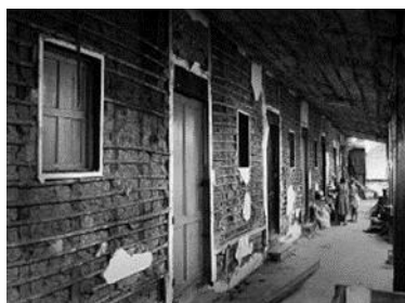
Figura 1.12 – Costruzione taquezal dopo il terremoto del 1986 (Langenbach, 2006 A)
