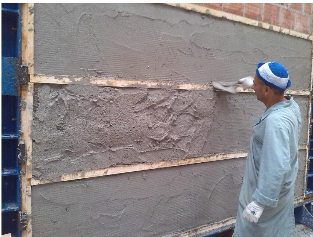
Figura 2.18 - messa in opera del secondo strato di intonaco e secondo strato di rete di armatura
