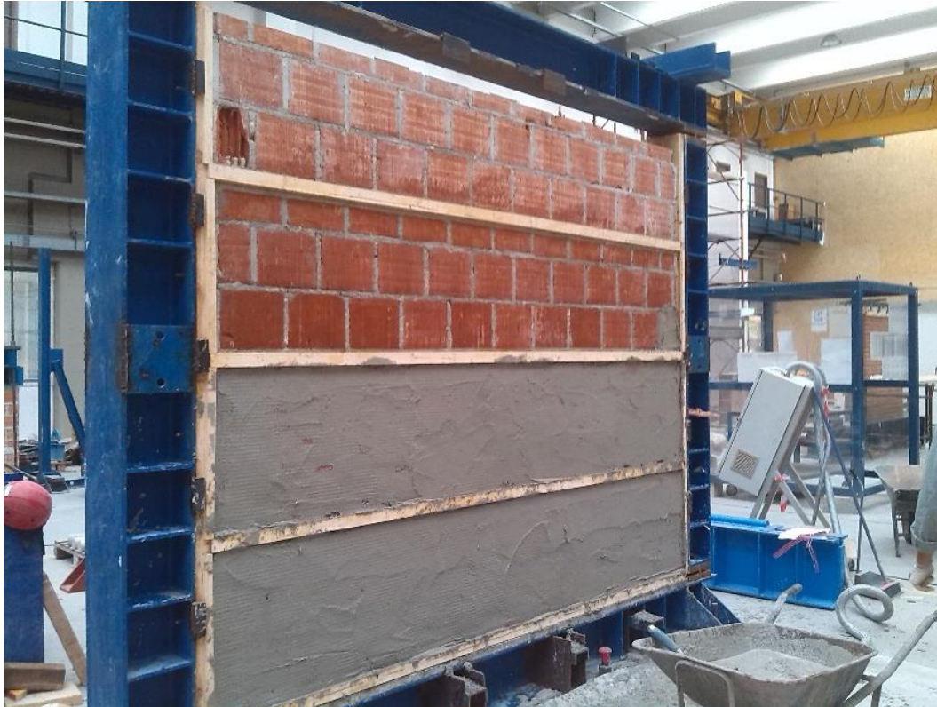
Figura 2.15 - Realizzazione primo strato di intonaco
