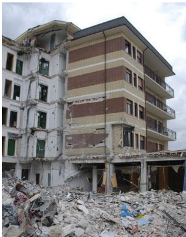
Figura 1.1 - Terremoto dell'Aquila 2009: un edificio in c.a. parzialmente crollato e con vistosi danni ai tamponamenti
